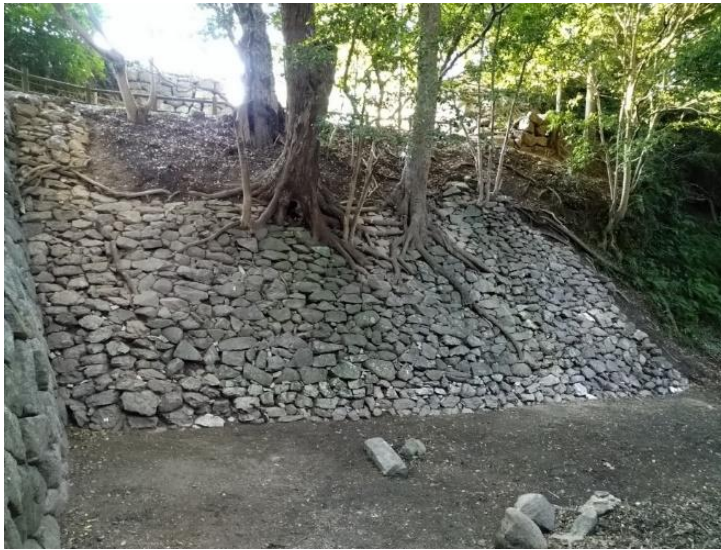
確認された石垣 （詳細は裏面参照）
