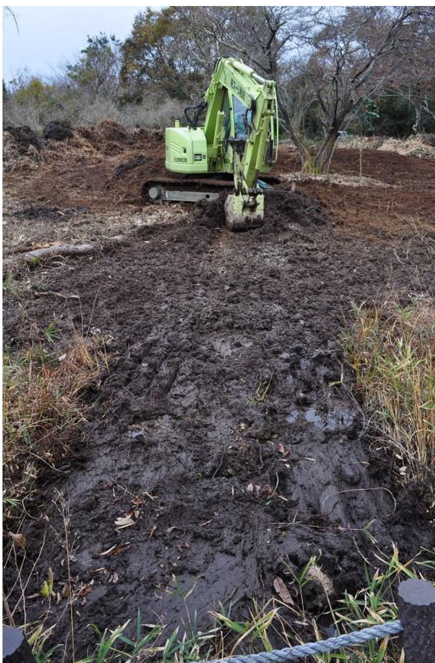
J地点湿地部分の実験区
