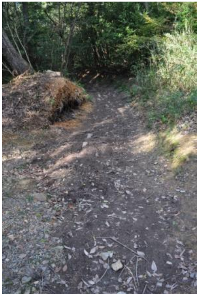
道路作業後（2013年11月20日）
